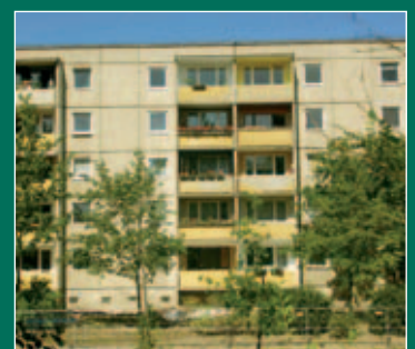
Sanierungen bei „Karl Marx“ Seite 13
